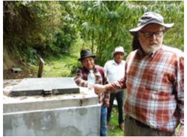
▲ Quellwasser Fassungsbälter für die Druckleitung in das Dorf Asama im Norden von Quito
